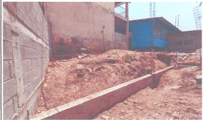
Foto 4: Área donde se contempla hacer el mejoramiento de la estructura tipo portico para cocina.
