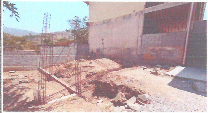
Foto 2: Área donde se contempla hacer el mejoramiento de la estructura tipo portico para cocina.
