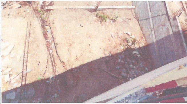
Foto 1: Área donde se contempla hacer el mejoramiento de la estructura tipo portico para cocina.
