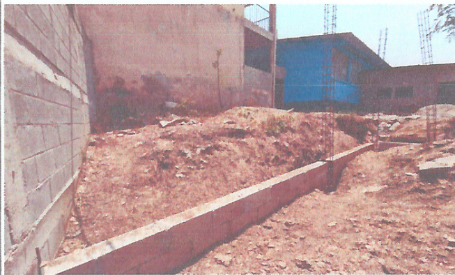
Foto 3: Área donde se contempla hacer el mejoramiento de la estructura tipo portico para cocina.
